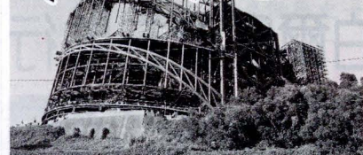
興建中的體育館鋼骨架構
